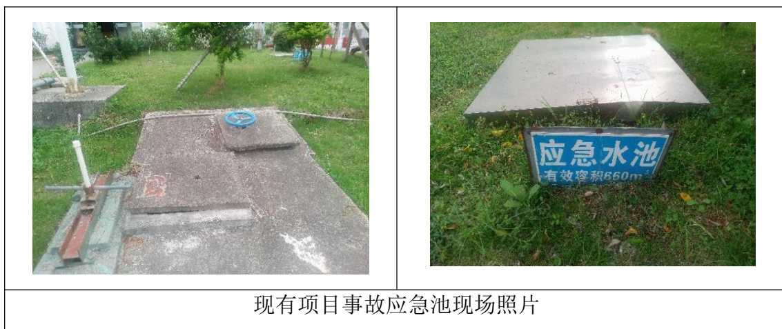
图 7.1-1 现有项目事故应急池现场图
